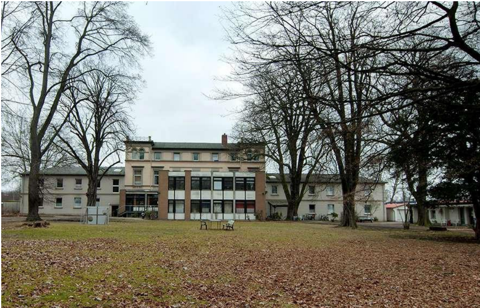
DHJ Verwaltungsanbau mit Speisesaal und Verwaltungsgebäude Außengelände (alt)
